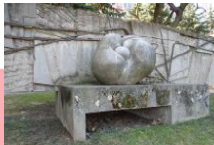
Stav před vyčištěním (03/2015/JJ)
