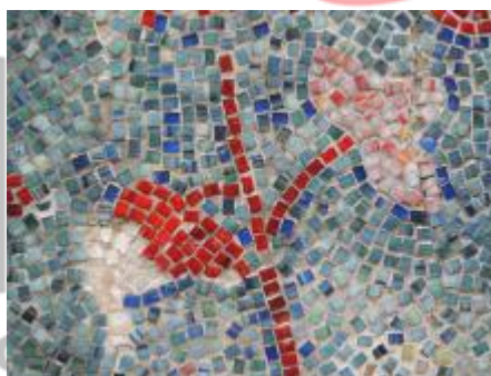
vlevo vydrolené kostky, vpravo prasklina, Jl 2016
