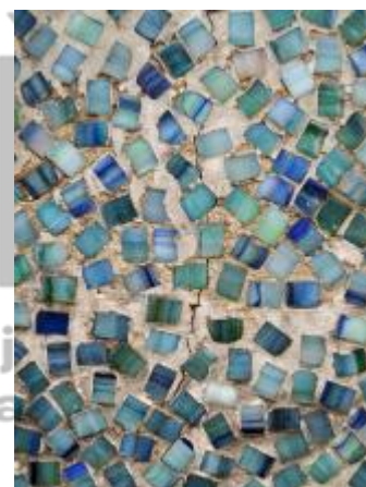
detail praskliny, v minulosti již tmelené, Jl 2016
