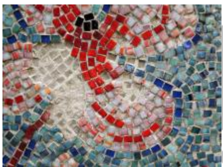
detail masivního vydrolení mozaikových kostek, Jl 2016
