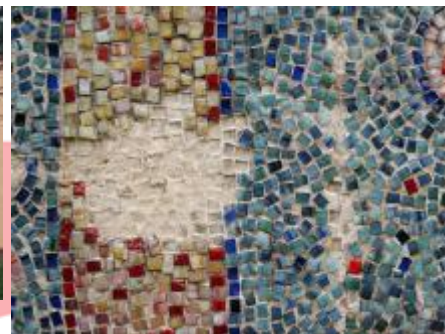
detail masivního vydrolení mozaikových kostek, Jl 2016
